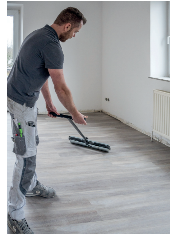
Das Handwerkerteam der Service gGmbH erledigte zuletzt die Elektro- und Handwerksarbeiten im Quality Hotel Bielefeld.
